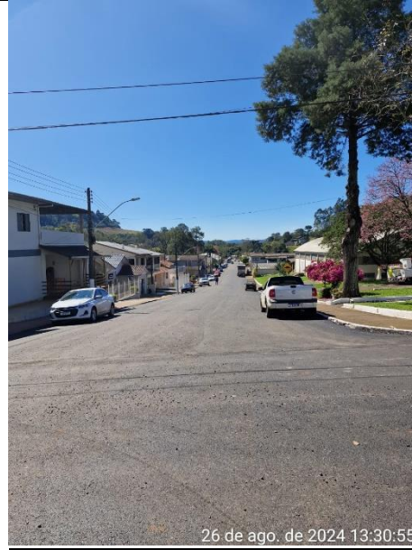
Figura 10 – Rua São Francisco
